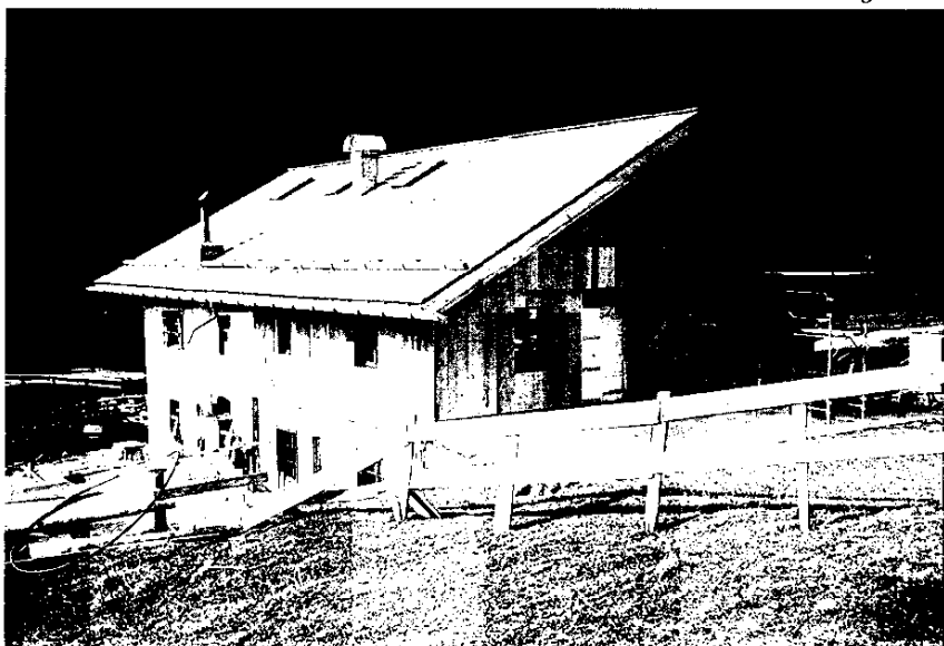
Lavori in corso a Malga ra Stua
