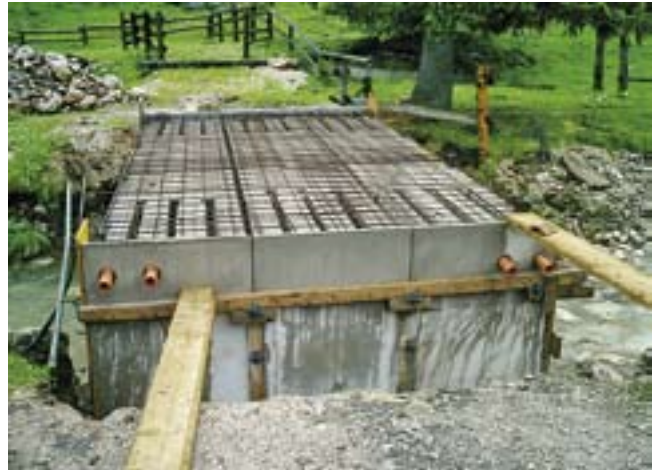
Ponte per stalla Ra Stua
