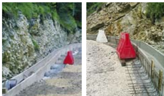
Cunetta strada Ra Stua
