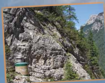
Vasca di presa acquedotto Ospitale
