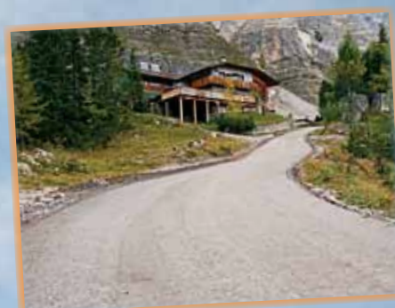
Strada verso il Rifugio Dibona
