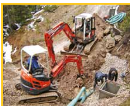
Sistemazione cedimento strada rifugio Dibona
