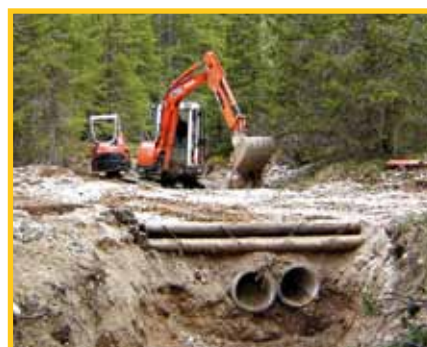
Landries. Ripristino attraversamento
