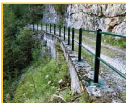
Strada Rocheta. Ricostruzione parapetto metallico
