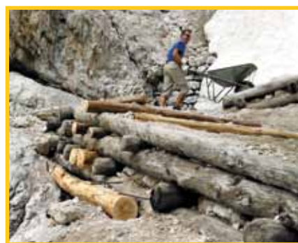
Riparazione arcia sentiero rifugio Giussani
