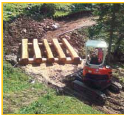
Rù de ra Cuòdes. Ripristino attraversamento
