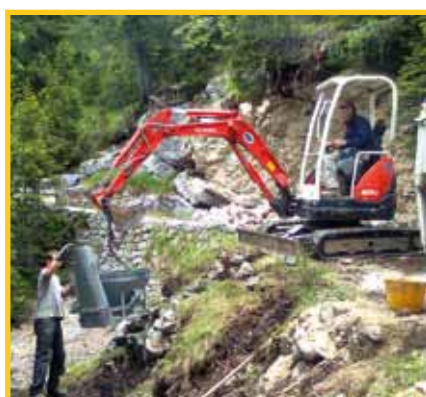
Recinzione opera di presa acquedotto Ra Stua fondazioni pali di sostegno
