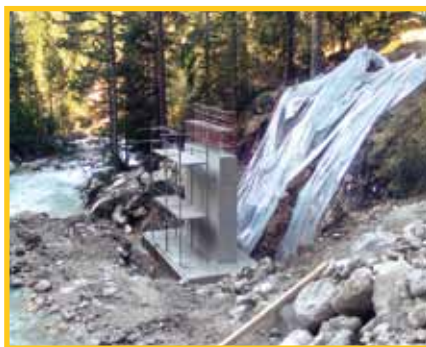
Pian de Loa. Spalla nuovo ponte
