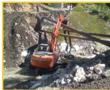
Pian de Loa. Costruzione struttura di servizio
