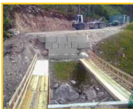
Pian de Loa. Struttura di servizio e opere per la posa del ponte in carpenteria metallica
