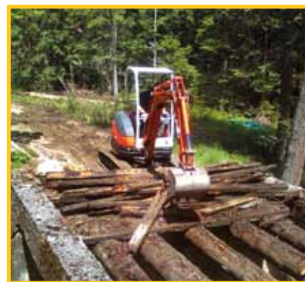
Valbona. Rifacimento impalcato ponte
