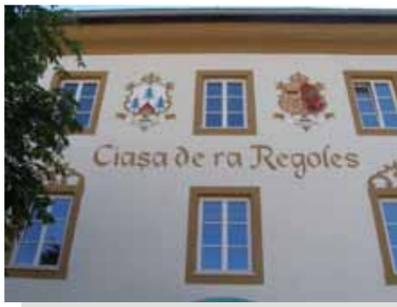
e arricchite le decorazioni attorno agli infissi. Questi ultimi sono stati interamente sostituiti, come anche il portone di ingresso agli uffici. All'interno invece – in prossimità degli infissi – è stato modificato il telaio dell'edificio con un lavoro di coibentazione e sono state ridipinte le pareti interne delle sale ospitanti il Museo Rimoldi. È condivisibile o meno il pensiero di Victor Hugo, secondo il quale "l'architettura è il grande libro dell'umanità". Tuttavia un edificio, oltre
