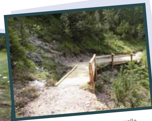
Podestagno - costruzione passerella
