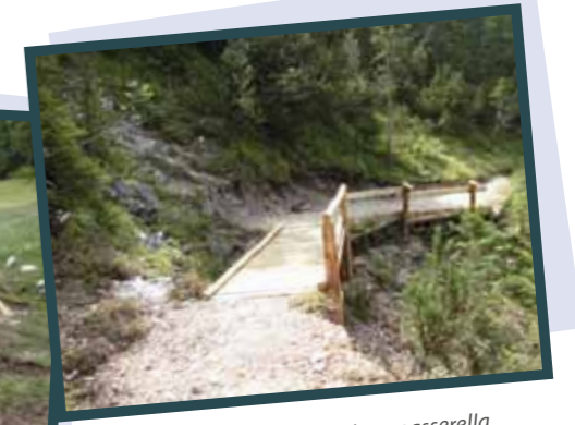
Podestagno - costruzione passerella
