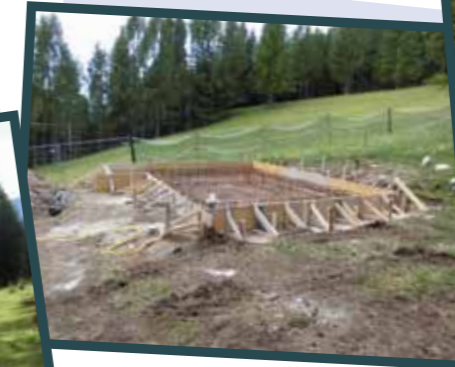
Fondazioni Cason de Castel
