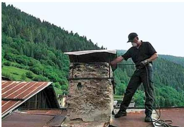
**regolare pulizia della canna fumaria;** il mantenimento della luce della canna e il suo regolare tiraggio si ottengono con la rimozione di eventuali incrostazioni bituminose ed altre sostanze incrostanti. La pulizia della canna fumaria, operata da professionisti abilitati e certificati, garantisce anche un regolare controllo degli standard di sicurezza da incendio e degli standard di qualità delle emissioni inquinanti.
