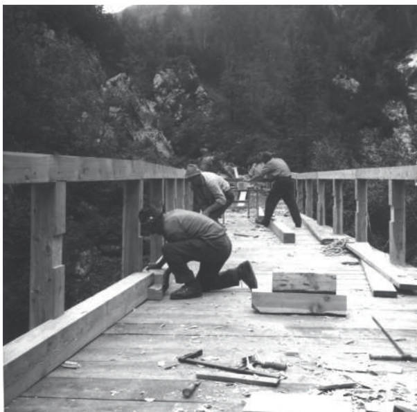
Squadra A.S.CoB.A. - Costruzione ponte
